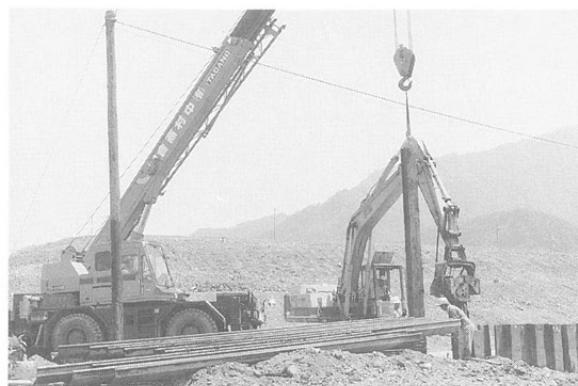
止水鋼矢板の打設（B 2 地区）
