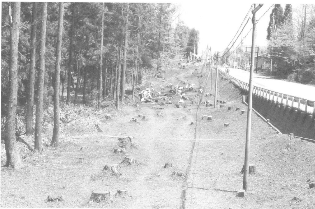
下段調査区作業風景 (南西より、奥が上段調査区)
