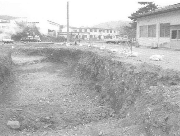
C区全景 (北より)
