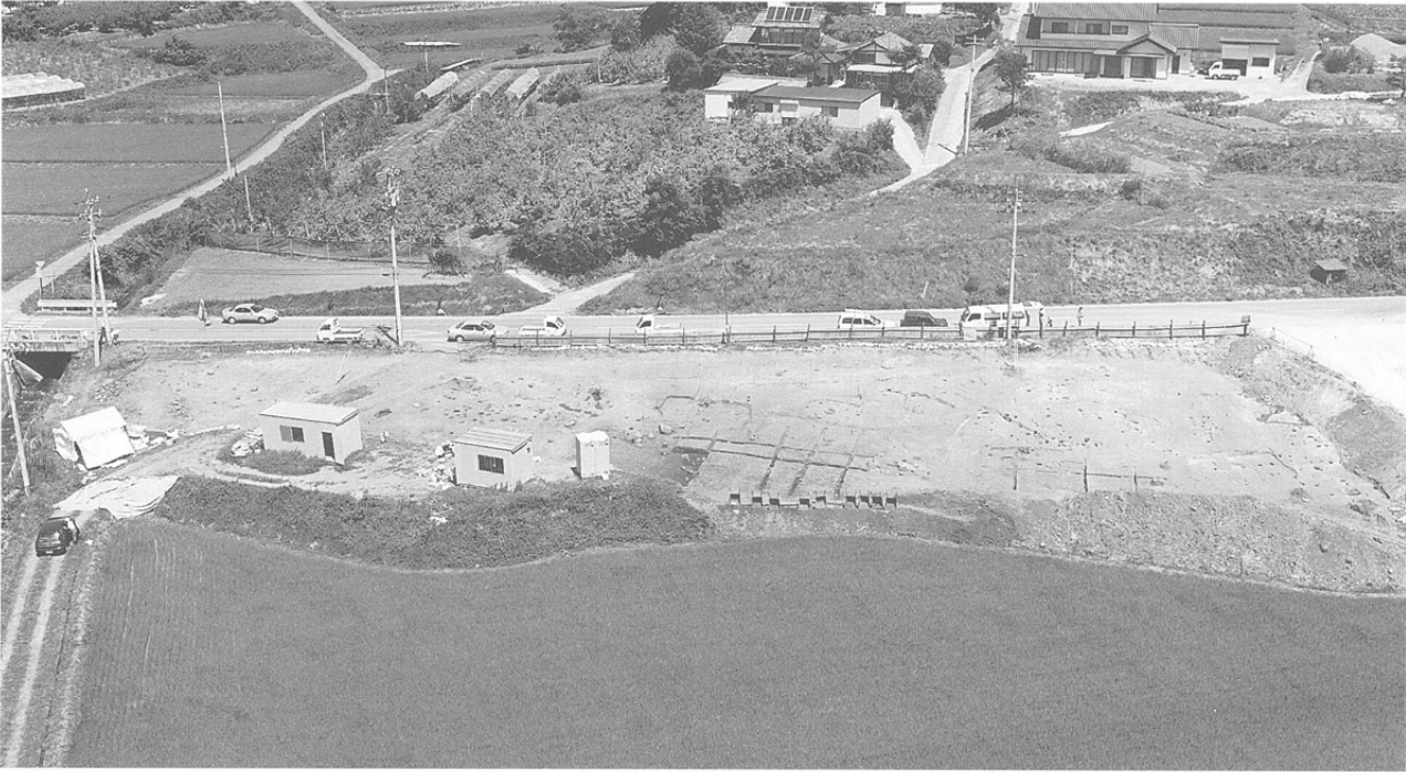
平成11年度調査 部分(南東から)
