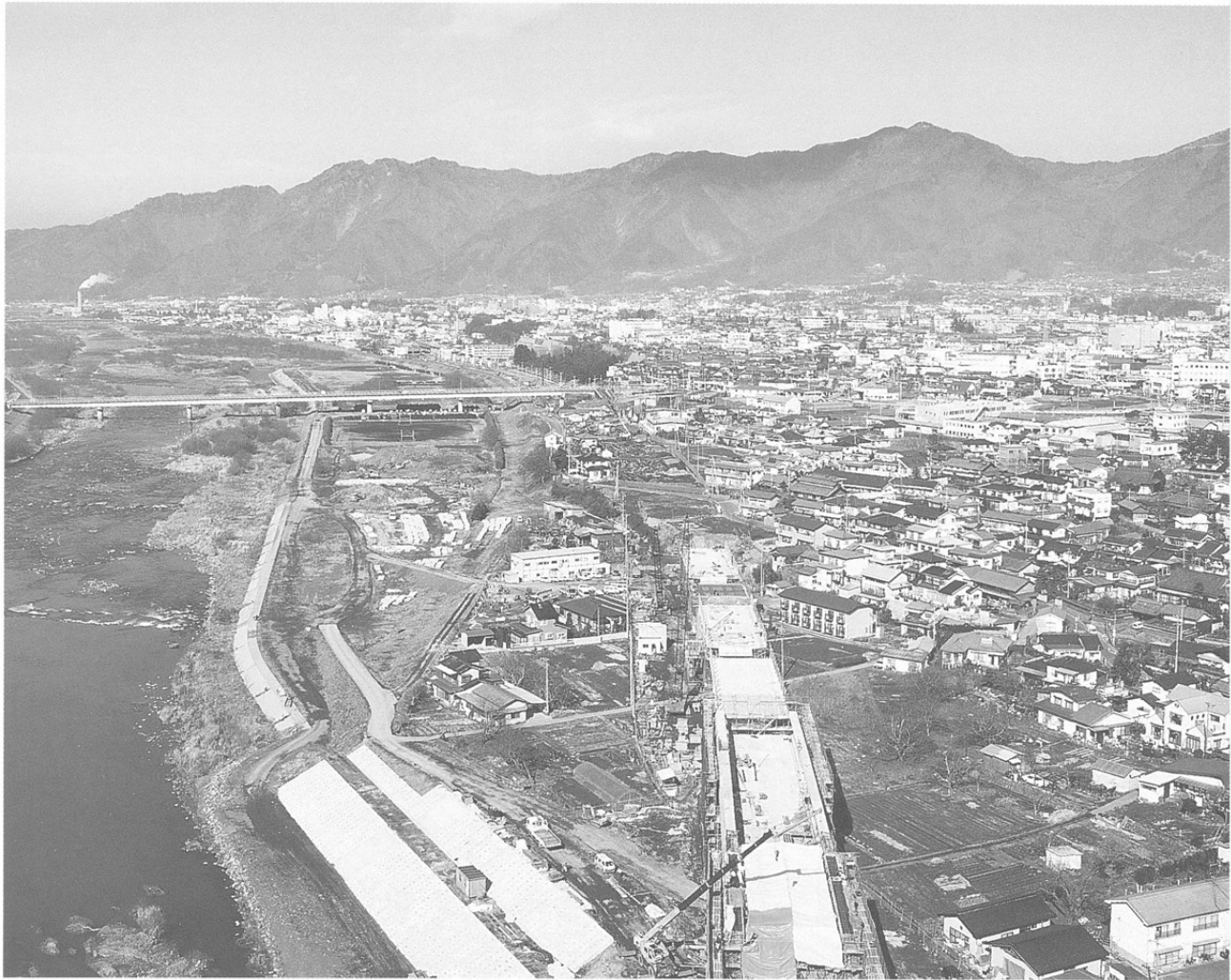
新幹線路線遠景 (ハープ橋より 上田市街を望む)
