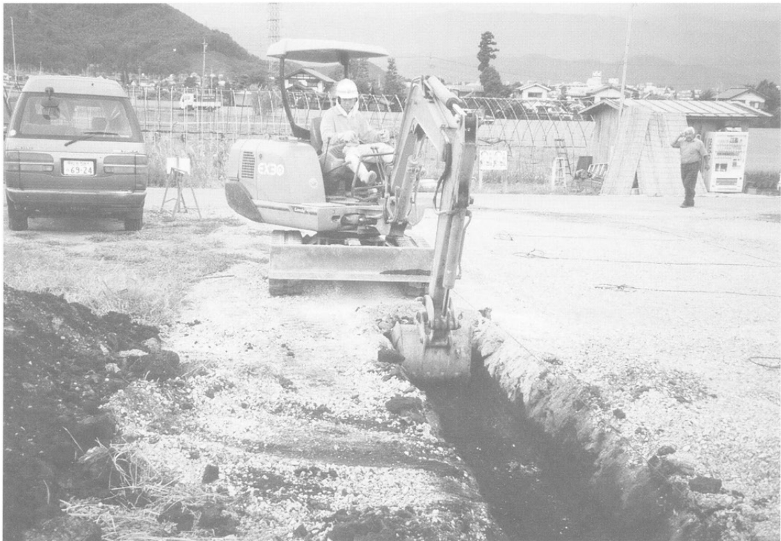
重機による除去作業
