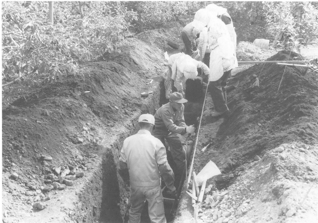
Fトレンチ掘り下げ
