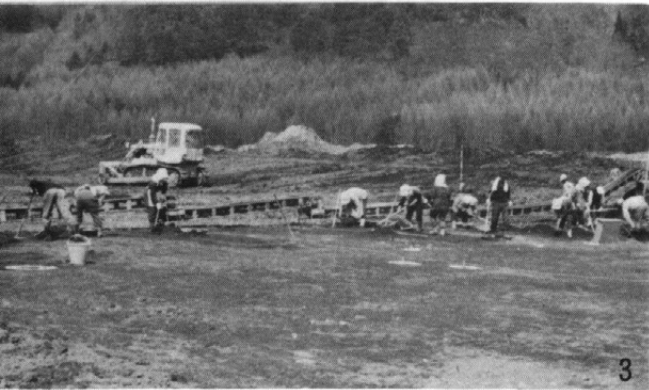
3. 表土除去作業 (昭55借)
