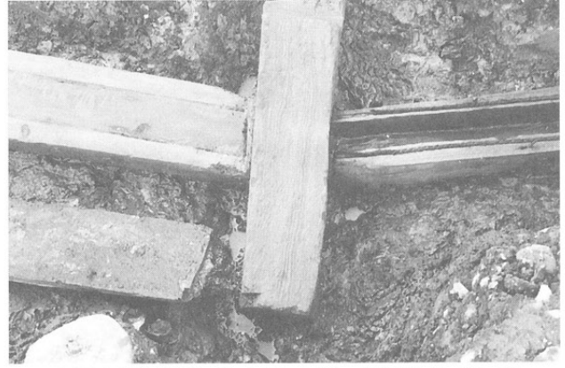
木樋上蓋（左）と中蓋（右）を取りはずし後
