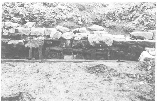
第8号建物址（基礎杭、胴木出土状況）
