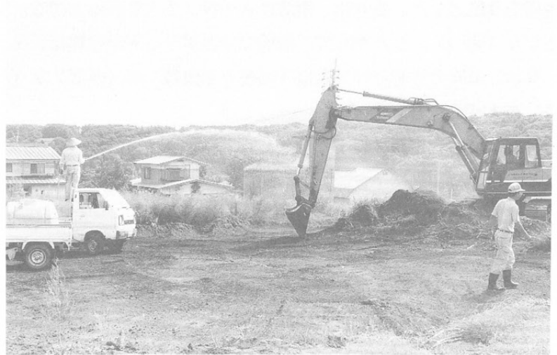
ほこりじめしのための散水作業 また、遺構面への散水も行った。
