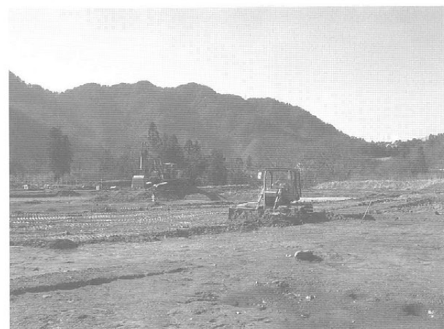
243 保護工事の様子
