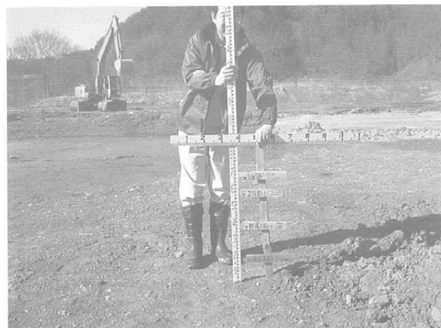
241 盛土保護工事の開始
