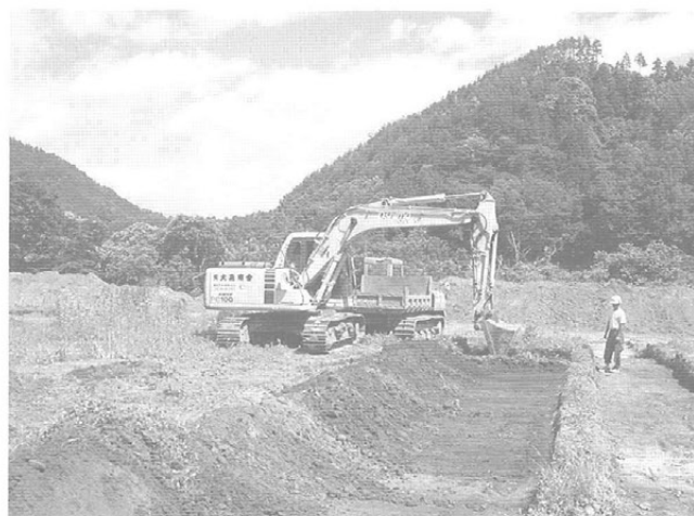
233 重機による表土剥ぎ
