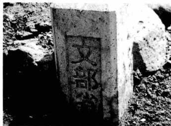
第4図 史跡境界 杭設置状況
