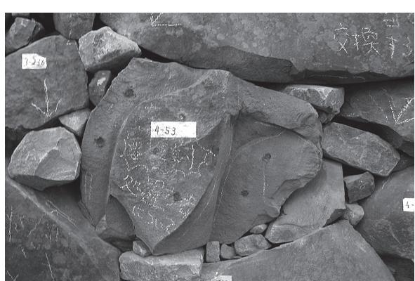
写 7-5-9 詰石とポルトによる補強（事例②）
