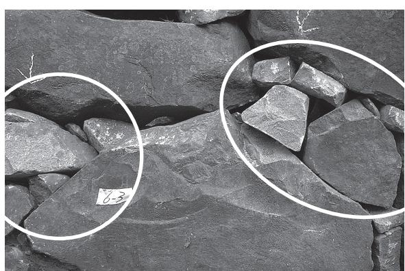
写7-4-17 施工後(破損石材の補強)
