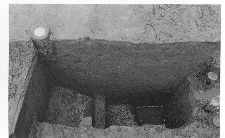
5区 水路内の堆積状況
