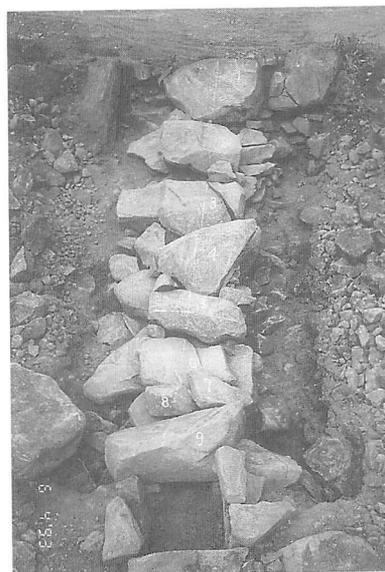
第21図 水抜き暗渠1-1 (蓋石状況)
