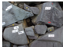
控えの長い詰石と交換
