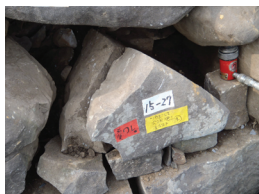
石材破損（交換）
