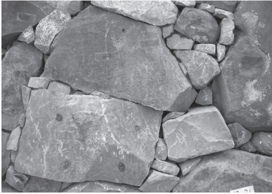
写5-8-8 同上 ボルト補強 (施工後)
