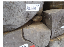
石材斜め破断補強
