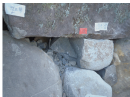
破損詰石除去交換
