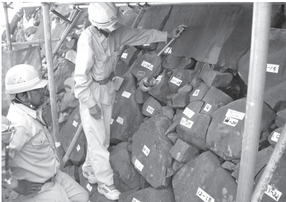
写5-8-2 補強工法の現地協議
