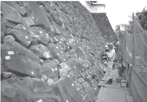
写5-5-6 施工前記録調査
