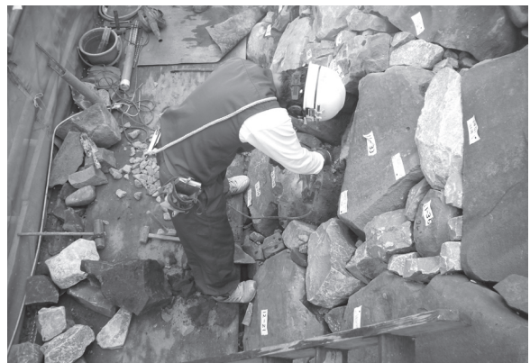
写5-5-9 詰石施工 (補強)
