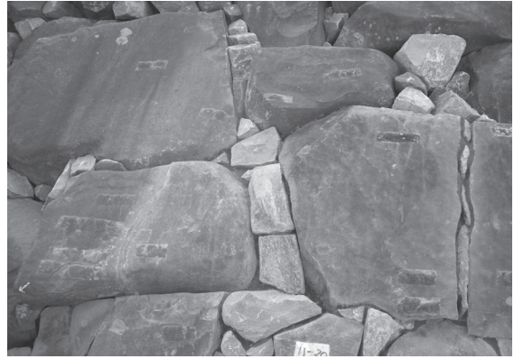
写5-8-9 ボルト・ボンド補強集中箇所 (施工後)
