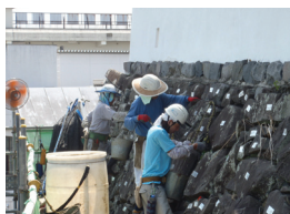
石垣の清掃作業
