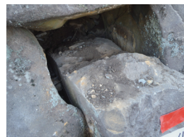
石材前後破断補強
