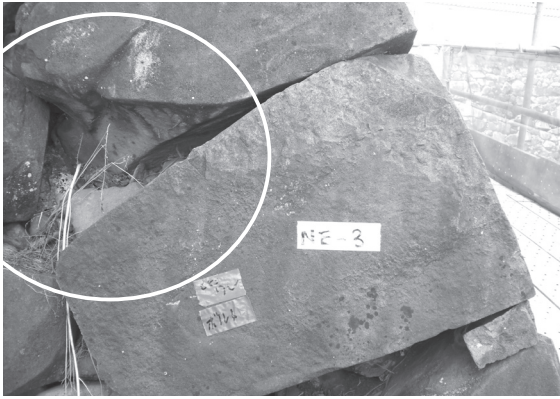
写5-7-4 对比事例② 施工前
