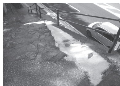
写7-1-4 復旧後の状況
