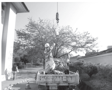
写5-3-1 計量作業状況
