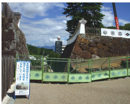
作業箇所の安全確保
