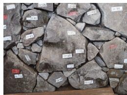
ボンドを使用するの詰石補充
