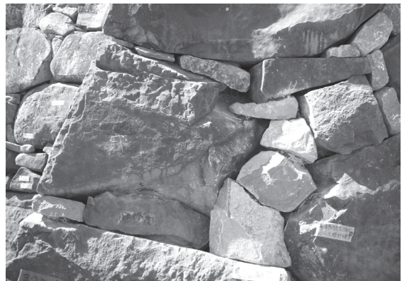
写5-8-13 除去・交換、ボンド補強 (施工後)
