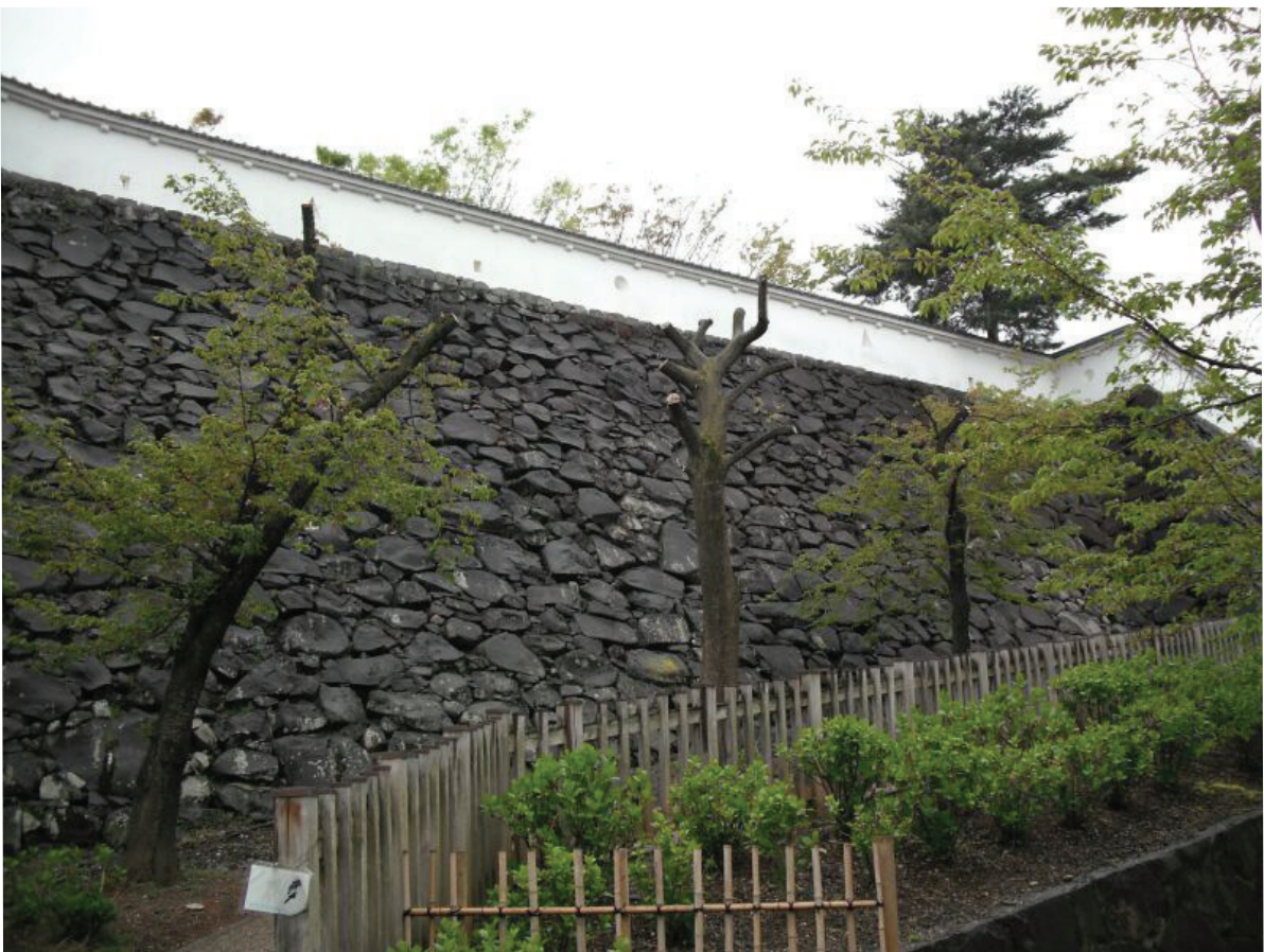
I-32石垣施工前
