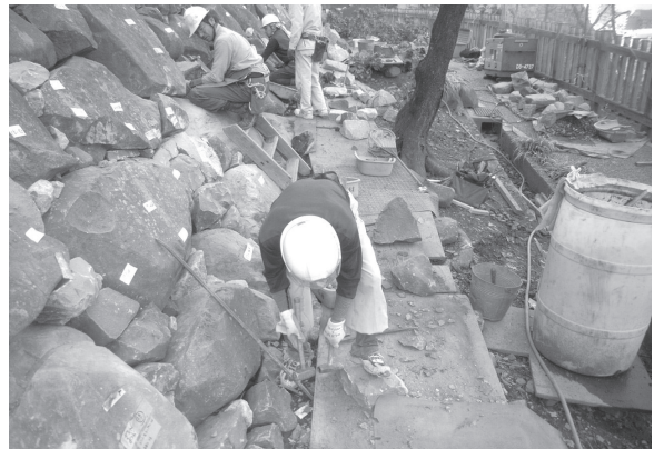
写5-5-7 詰石施工 (石材加工)
