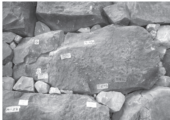
写5-8-5 同左 ボルト補強(施工後)
