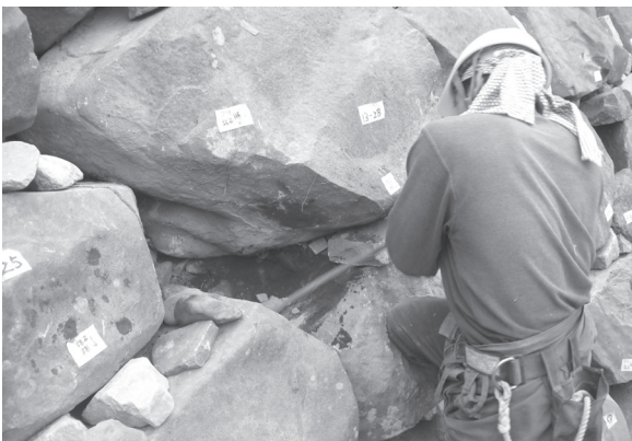
写5-5-8 詰石施工 (栗石充填)
