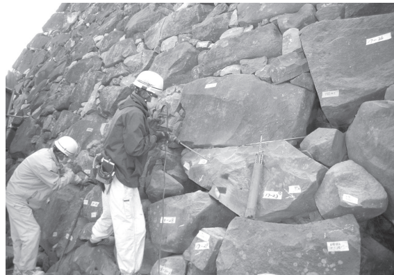
写5-8-3 ボルト施工状況
