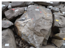
石材表面破損部除去
