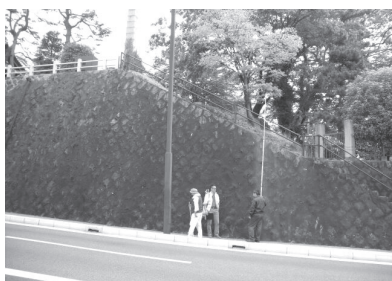
写7-1-2 現状の調査
