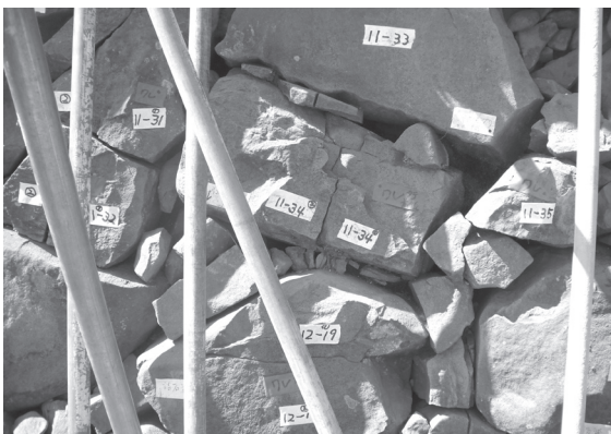
写5-8-6 前後破断石材(施工前)
