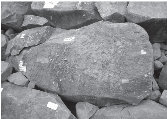
写5-8-4 玉ねぎ状の破断石材(施工前)
