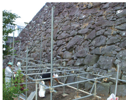
石垣に足場を設置
