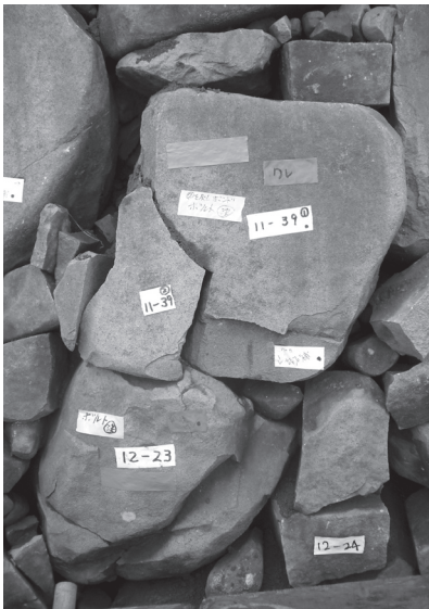
写5-8-10 縦破断 (施工前)
