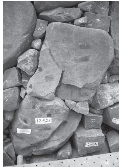
写5-8-11 同右 ボルト・ボンド補強 (施工後)
