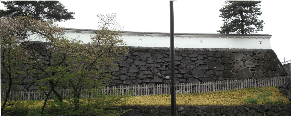
I-30石垣施工前
