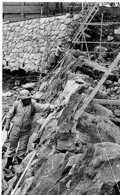
第83図 堀石垣修復工事風景
