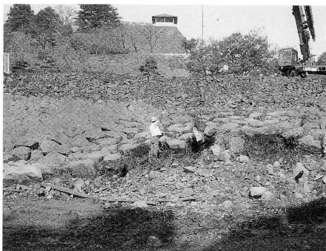
第99図 同左の石垣解体風景
