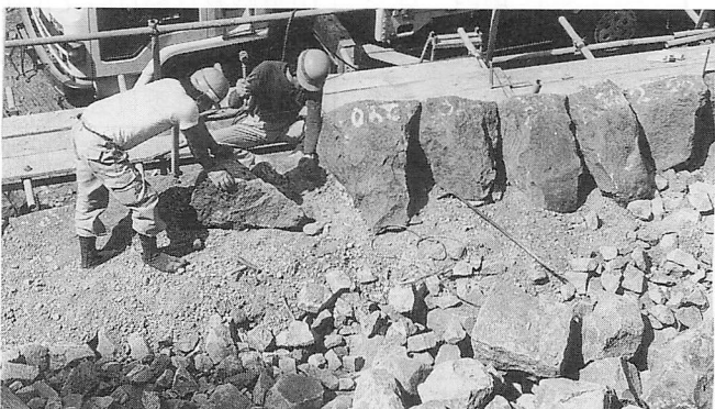
第10図 平成2年度修復工事風景
