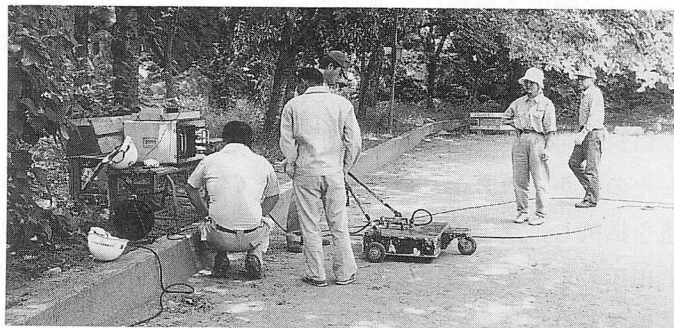
第16図 地中レーダー調査風景
