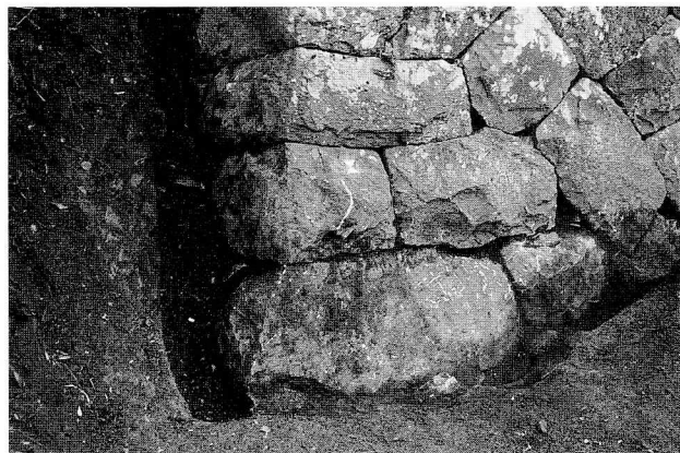
第34図 松陰門と柵門の中間の改修石垣根石
