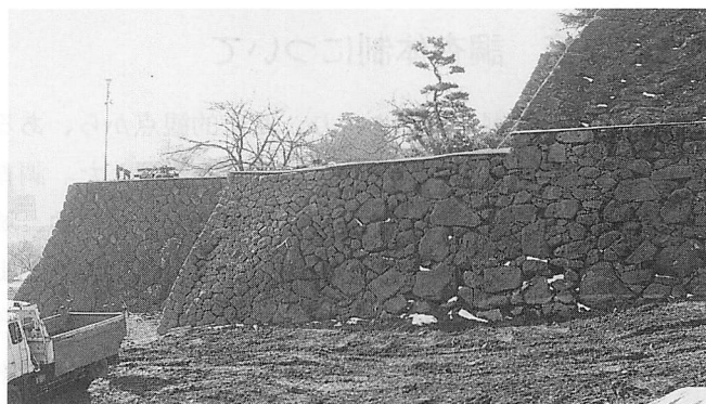
第7図 平成2年度修復工事前石垣
