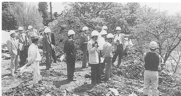
第11図 修復工事現場視察（91. 4. 20）
