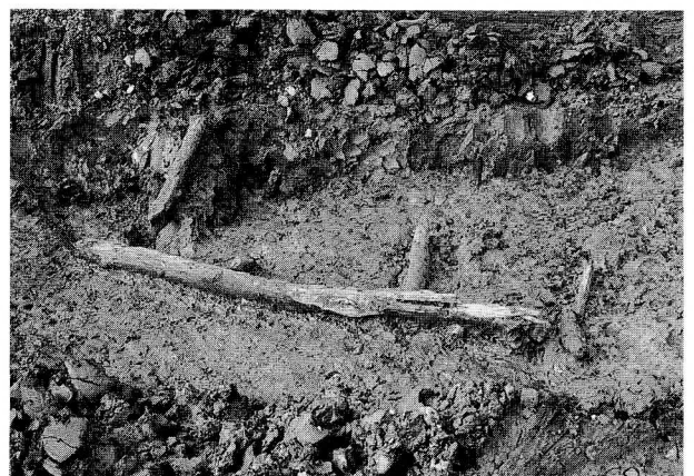
第94図 5番胴木滑り出しによる切断状況
