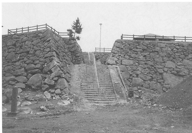
第47図 天守台石垣解体前
