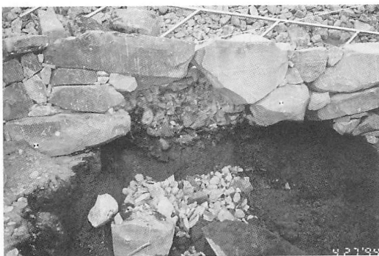
第53図 鉄塔基礎（南東部）
