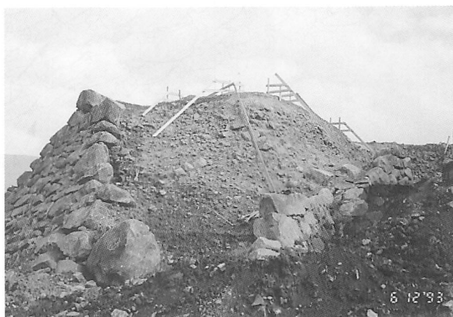
第48図 天守台石垣解体状況
