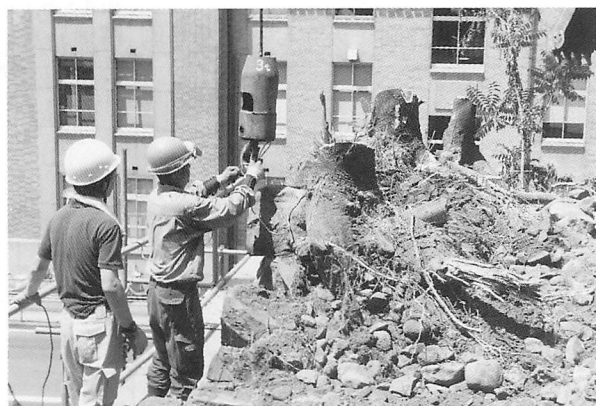
第73図 鍛冶曲輪門東西石垣解体風景
