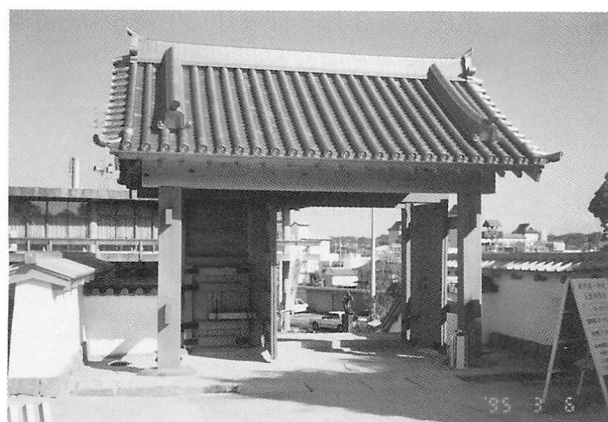
第5図 掛川城視察（四脚門）
