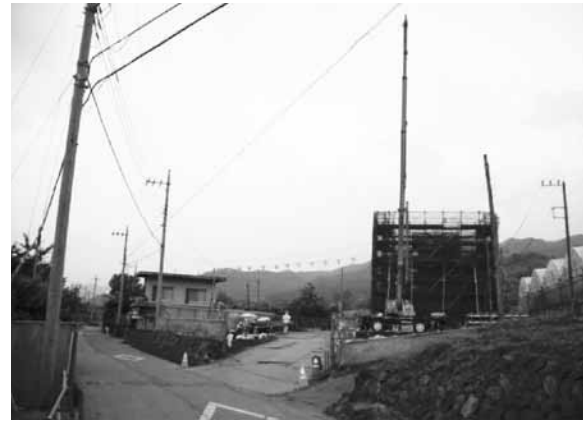
リニア実験線工事と発掘現場
