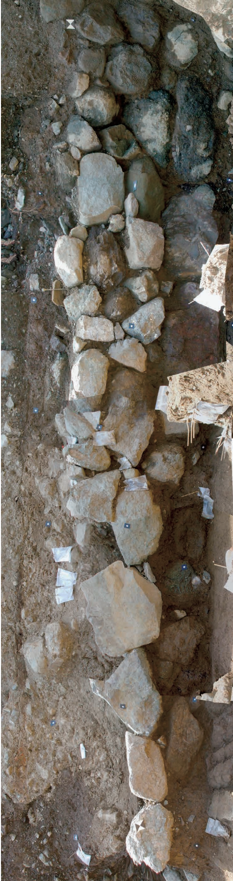
3号石垣（西から）
