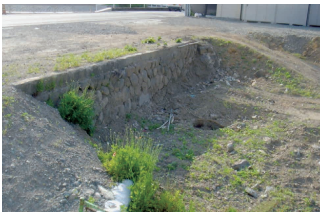
調査前県道際石垣（北東から）
