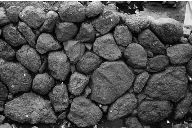
1号石垣（北から）
