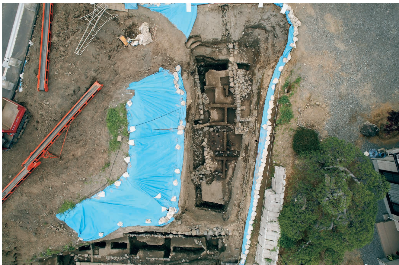
調査区 b 区俯瞰写真
