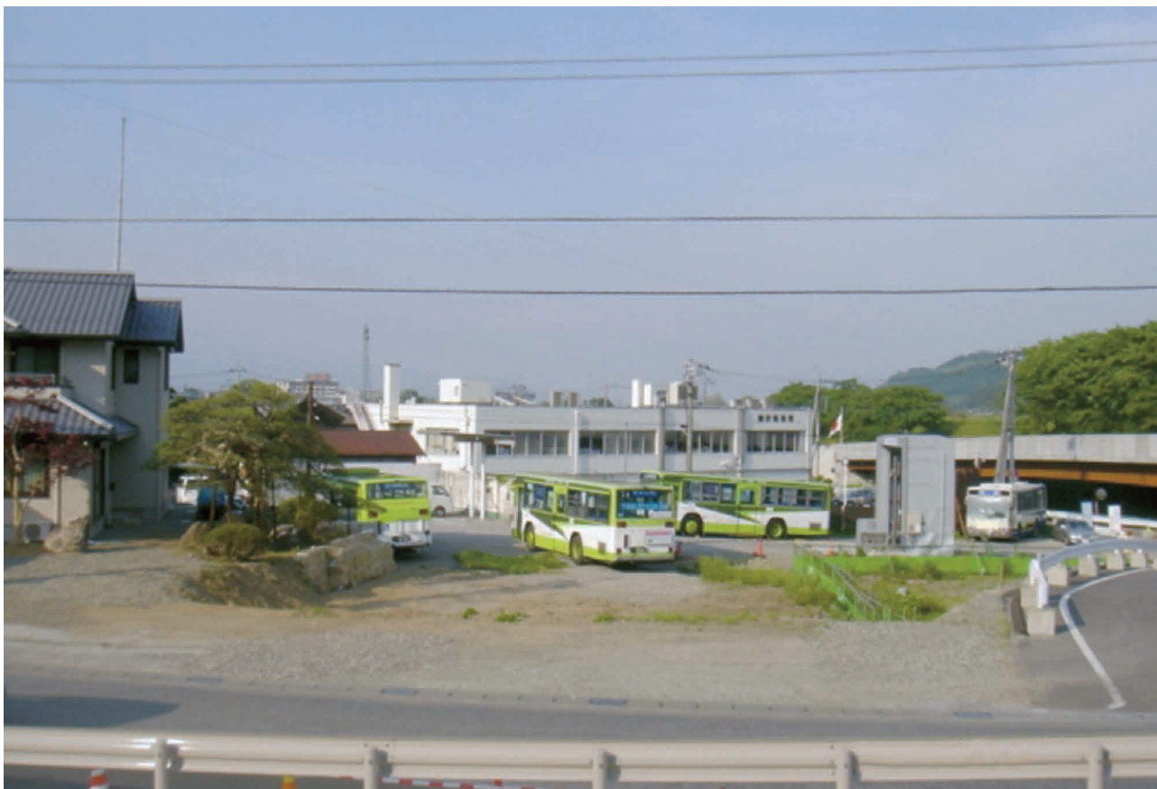
調査前全景（南から）
