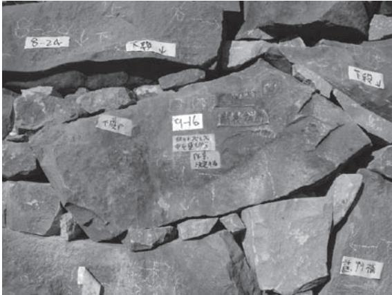
写5-8-8 同上 ボルト補強 (施工後)
