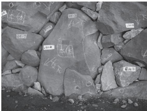
写5-8-5 同左 側面を除去、ボルト補強(施工後)
