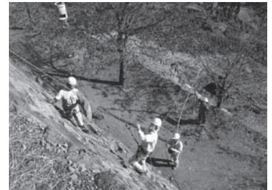
写6-2-13 破損石材除去作業状況
