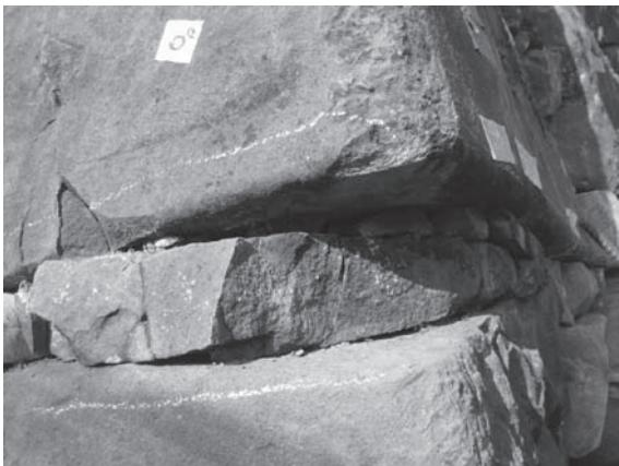
写5-8-12 すべり・詰石破損 (施工前)
