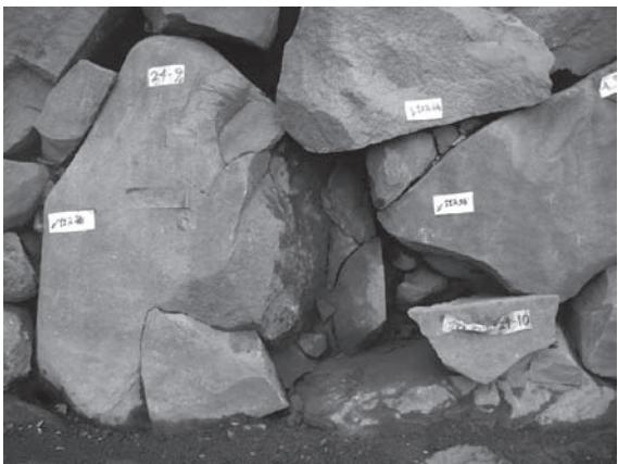
写5-8-4 玉ねぎ状の分割破断石材(施工前)
