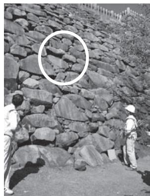
写6-2-10 破損石材除去状況
