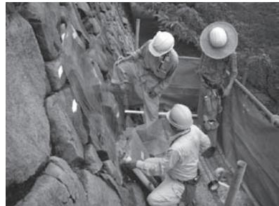
写6-2-6 破損箇所型取り状況
