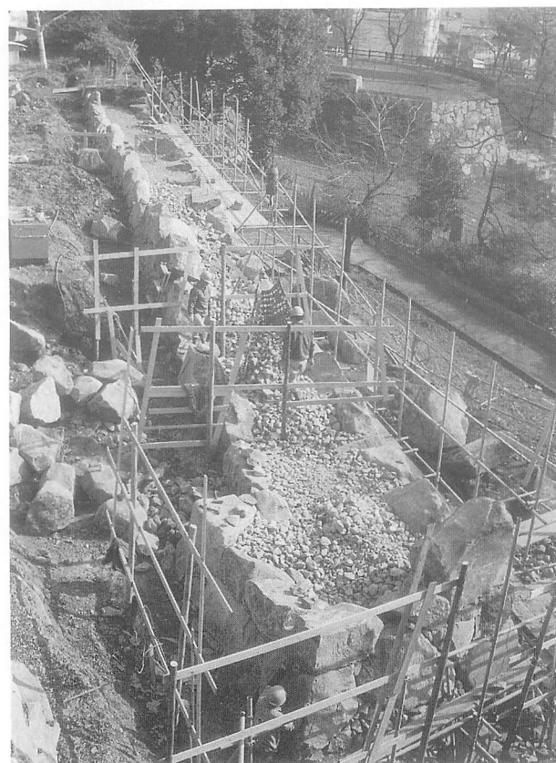
第41図 石積工事風景
