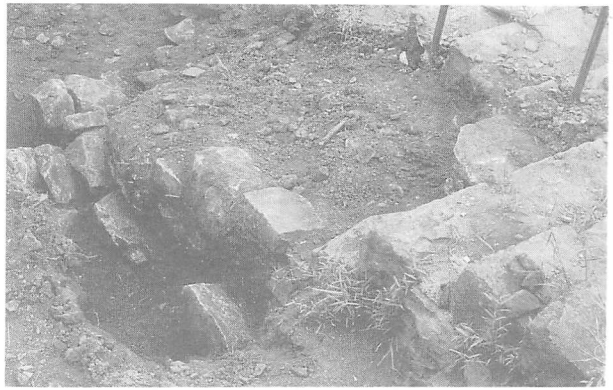
第23図 石段撤去状況
