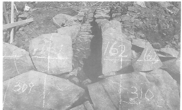
第44図 暗渠解体状況
