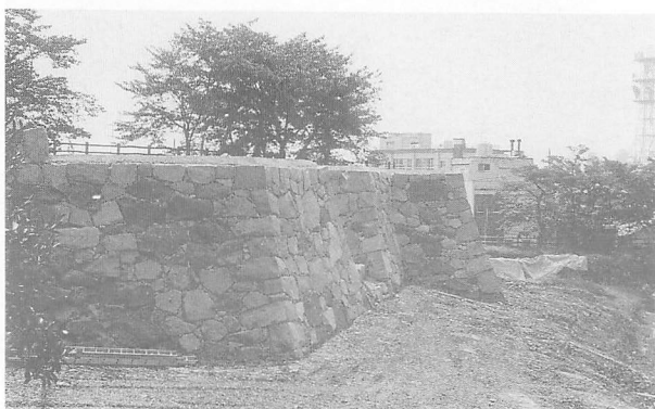
第30図 石積完成風景
