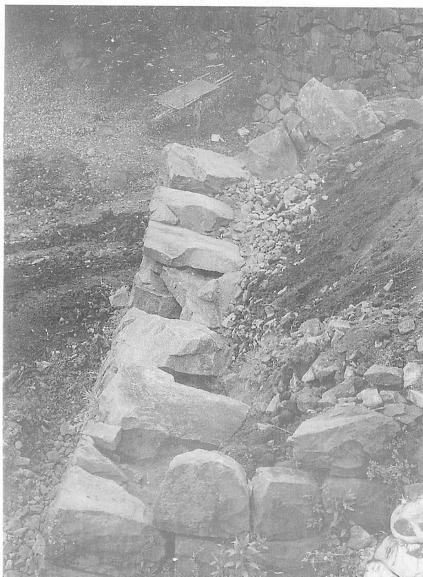
第29図 3番石垣裏込状況
