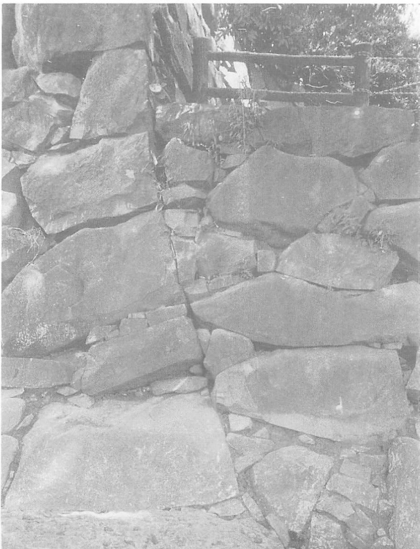
第24図 埋殺された稲荷曲輪石垣隅部
