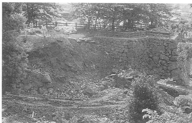
第27図 石垣解体風景
