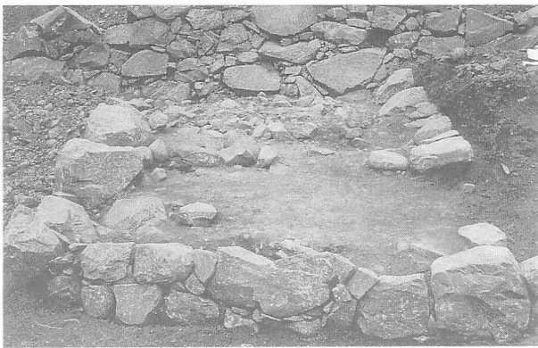
第22図 石段撤去状況
