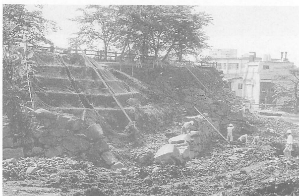
第28図 石積工事風景
