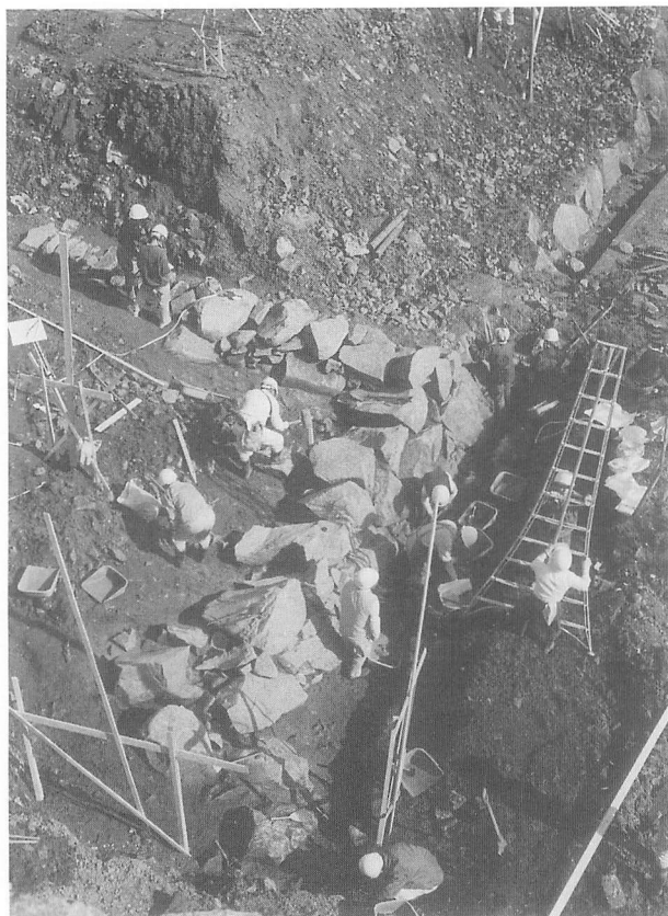
第40図 稲荷門付近調査風景（中央石列が暗渠）
