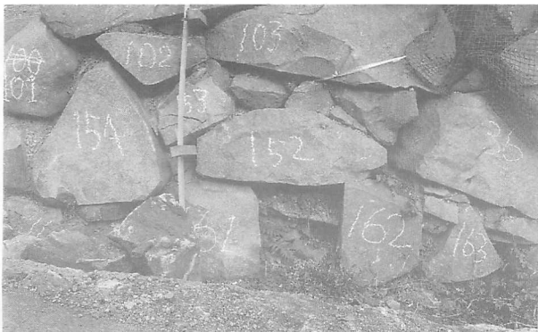
第43図 暗渠検出状況
