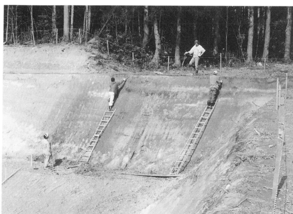
2.作業風景 (後方部西側)
