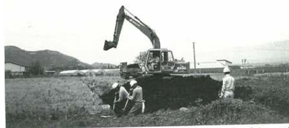
重機による表土除去作業(東から)
