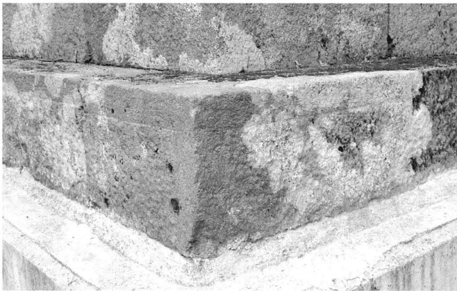
基壇最下壇の縁取（北東隅）
