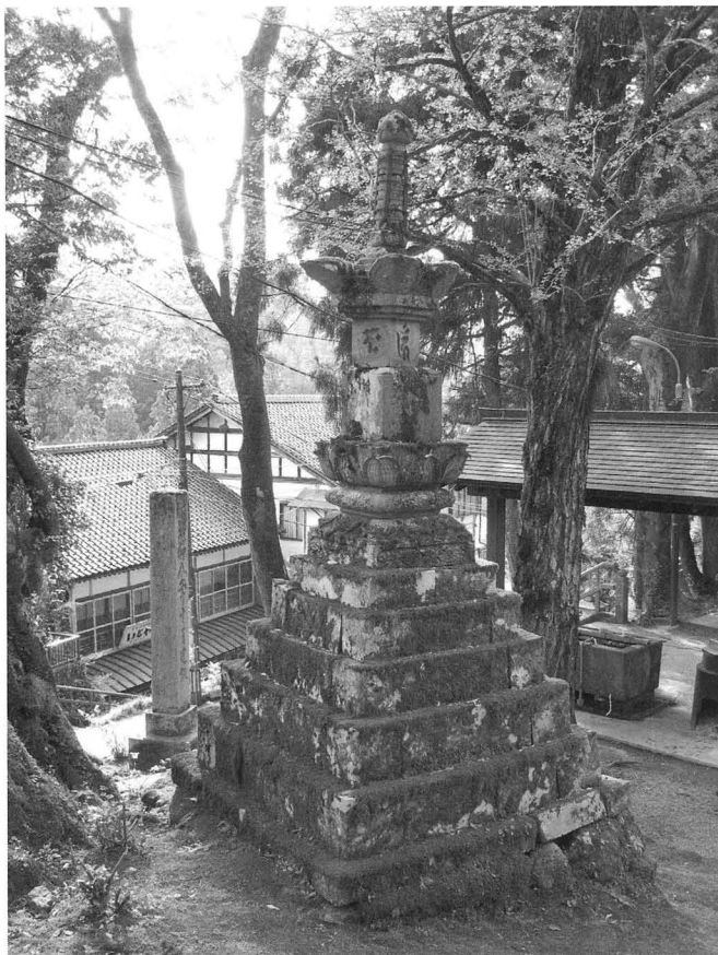
日石寺宝篋印塔（修復前） 南西から
