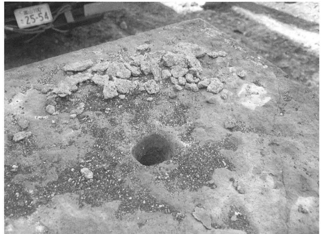
軸2上面のモルタル残片
