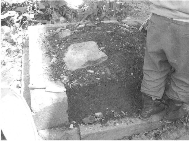
礎石経下の盛土状況
