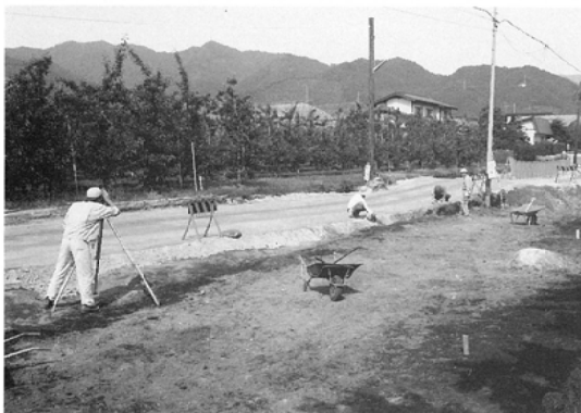
グリッド杭打ち作業（南西から）
