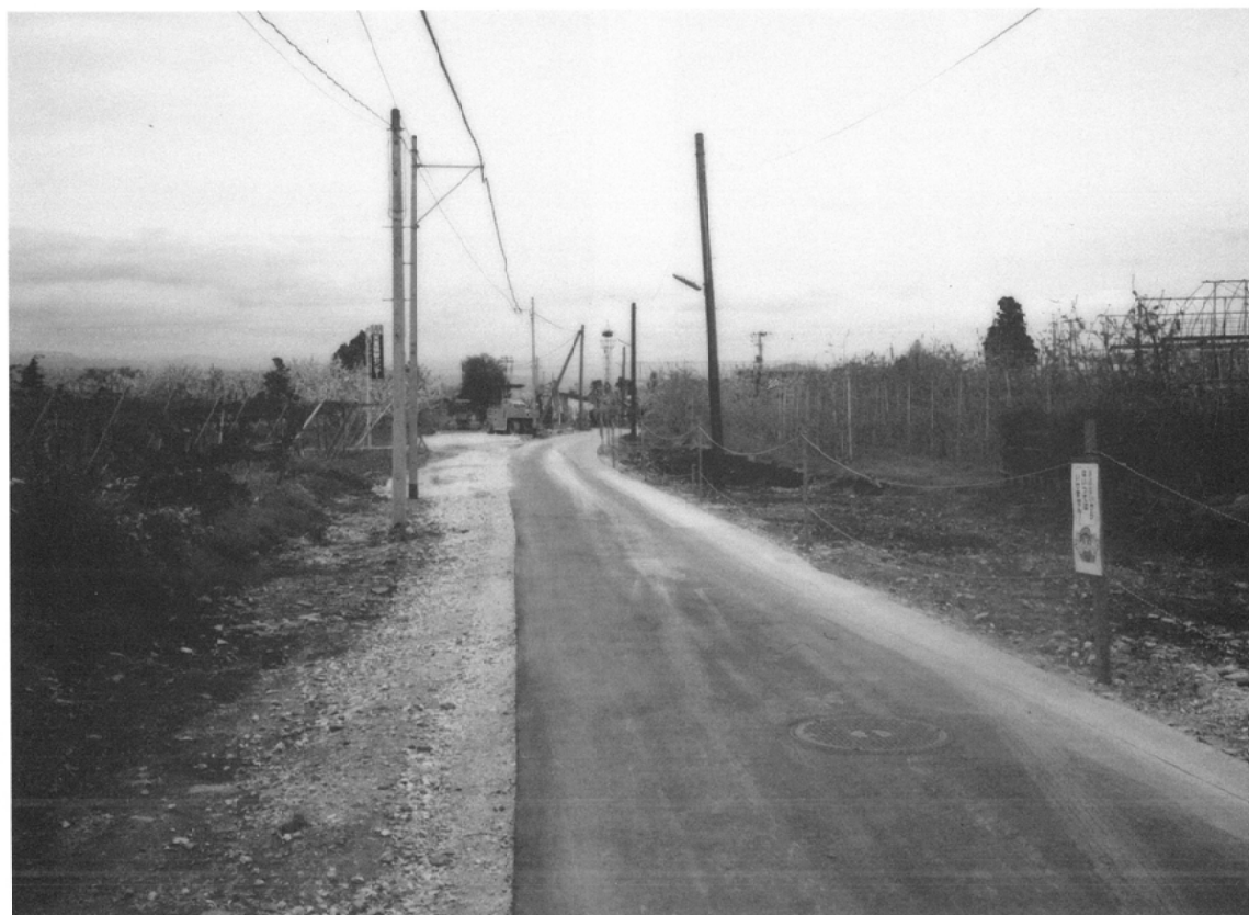
調査前状況（東から）
