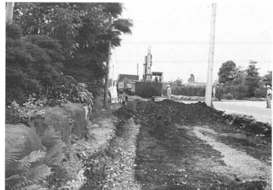
重機導入（東から）
