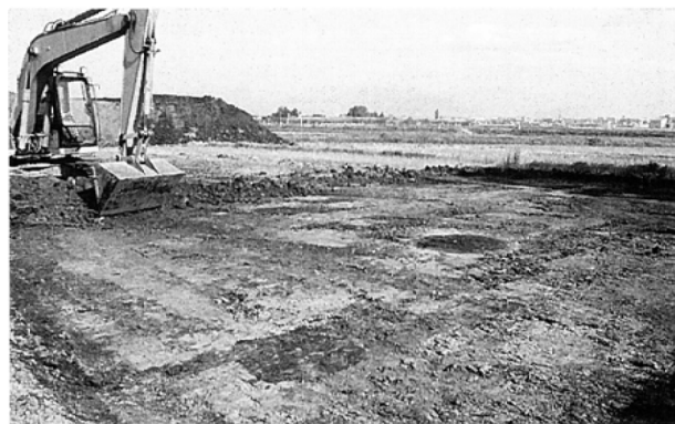
重機械表土除去
