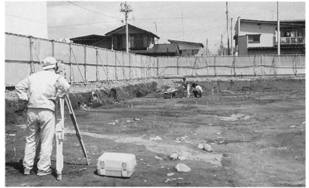
調査区杭打ち作業状況（南から）
