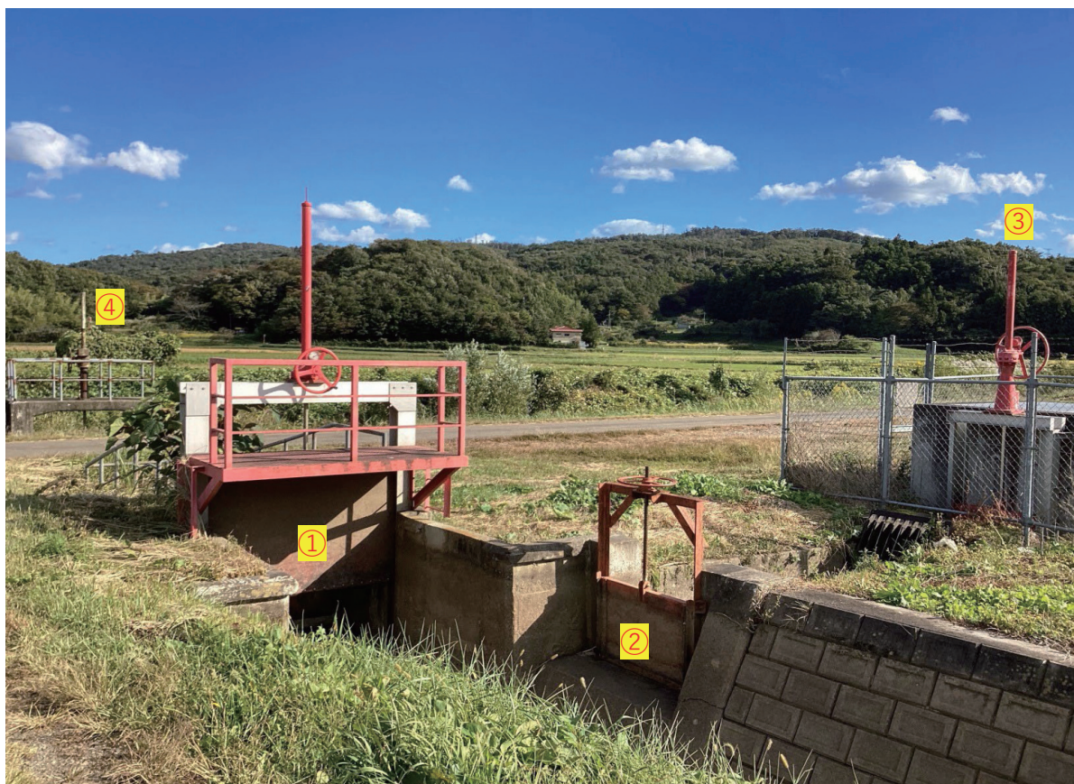
手前が大平中目向かい側の坂谷地区で農業用水が必要な時は①を閉め②を開ける。
