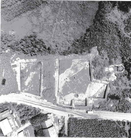
写真59 C区 全景空中写真
