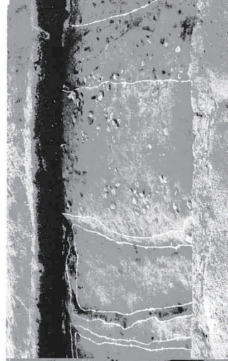
写真70 A区 6トレンチ土堤状高まり状況
