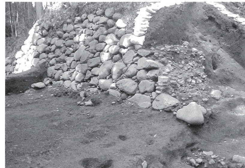
御前曲輪・通仲曲輪間地区 SV2 （南から）
