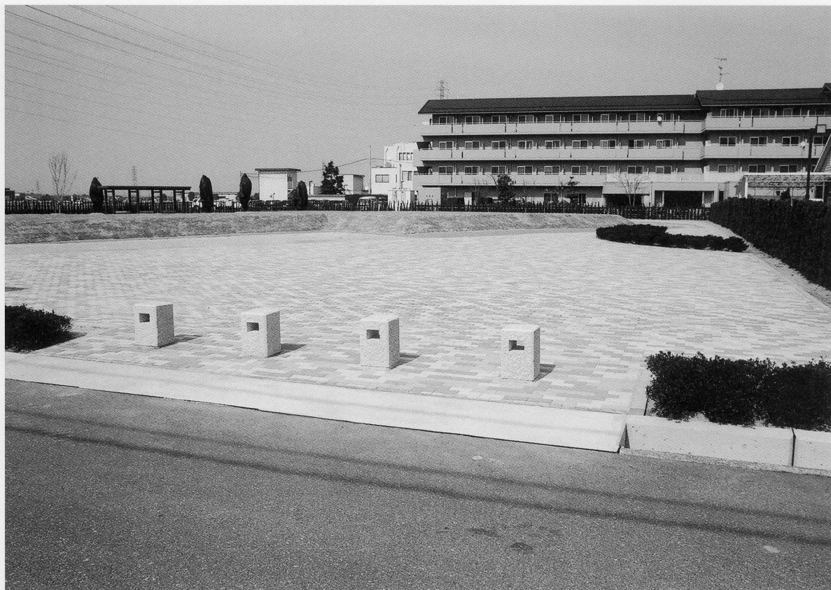
平成17年度保存整備工事 多目的広場インターロッキング舗装・車止め
