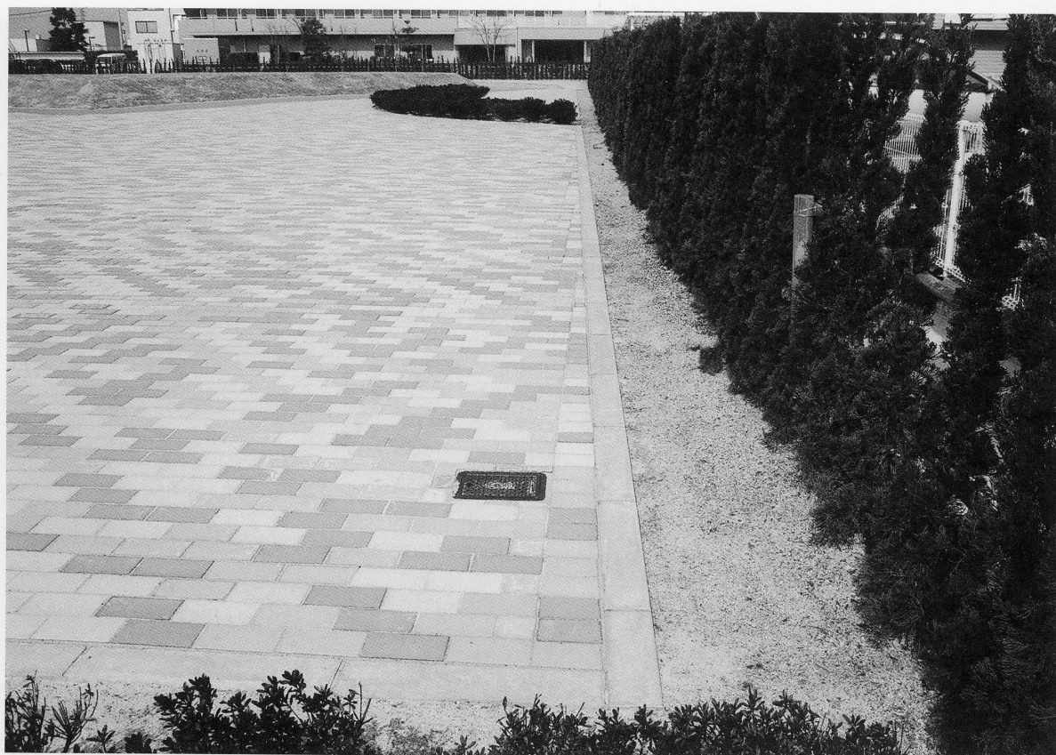
平成17年度保存整備工事 地先境界ブロック・散水栓
