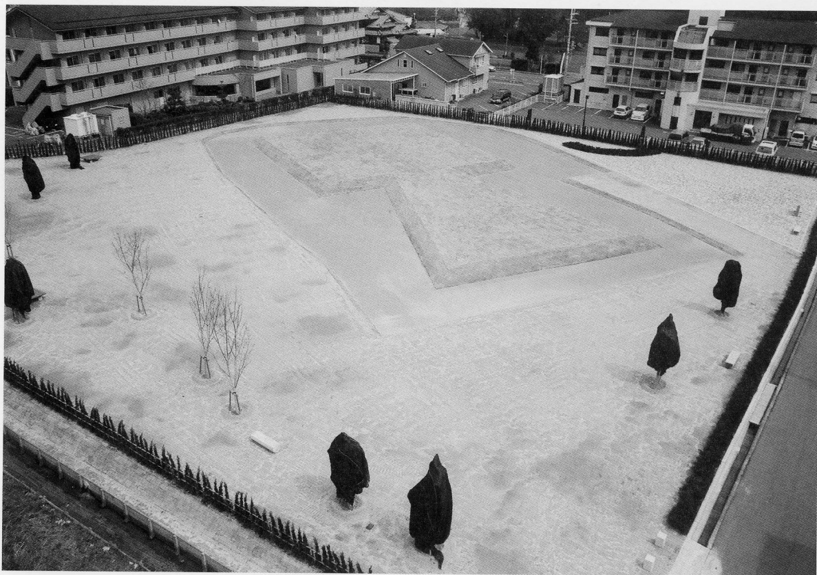
平成17年度保存整備工事 全景（西から）
