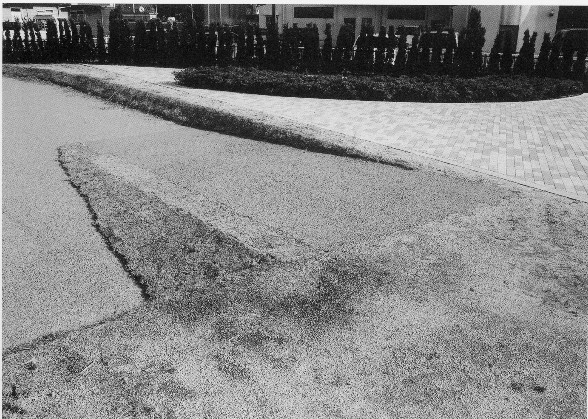
平成18年度保存整備工事 スロープ
