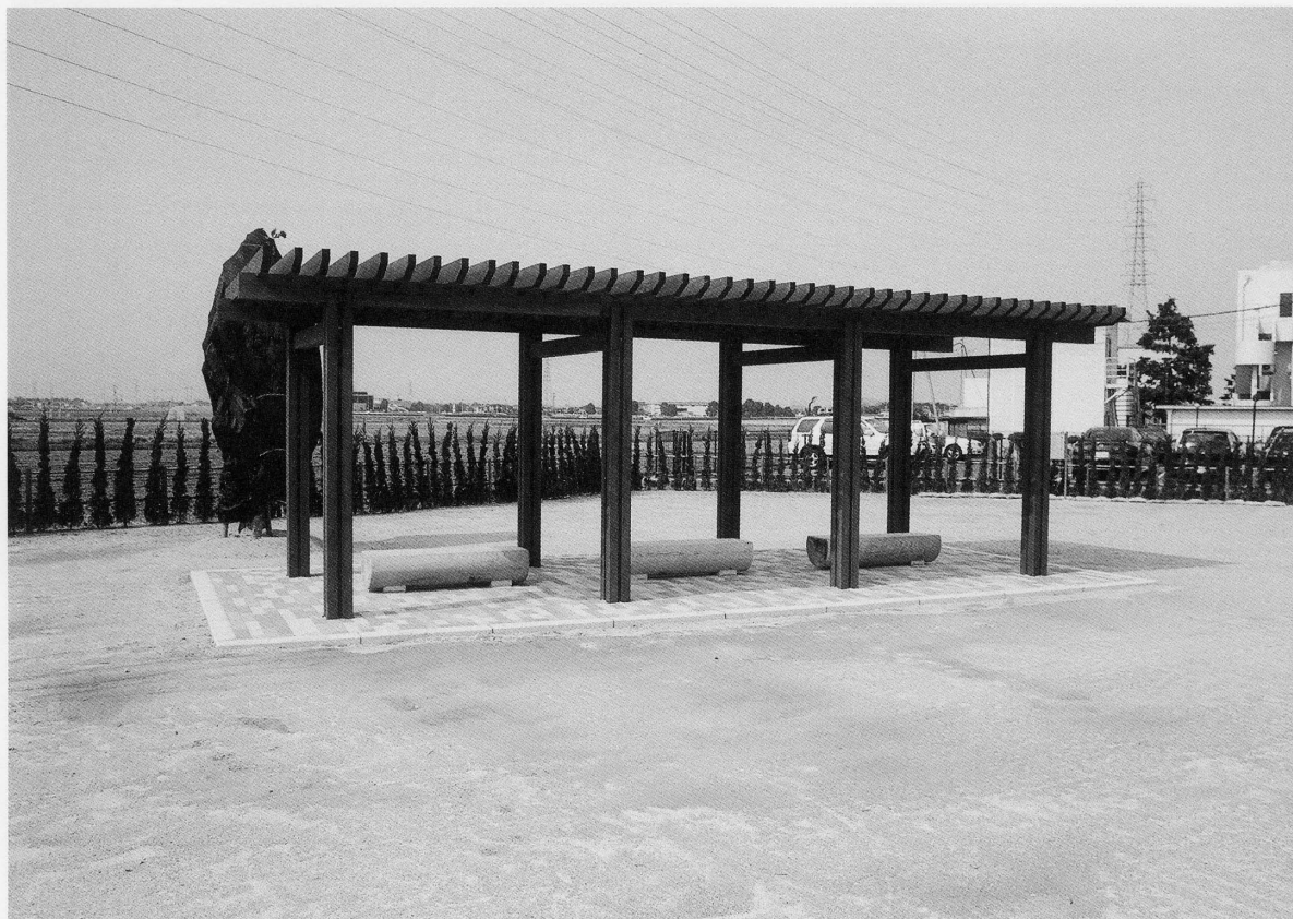
平成17年度保存整備工事 パーゴラ・ベンチ・インターロッキング舗装
