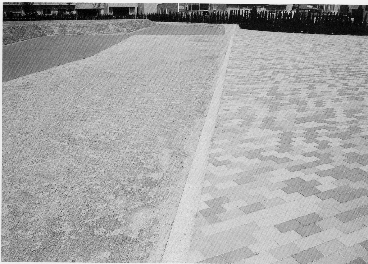
平成17年度保存整備工事 切石縁石
