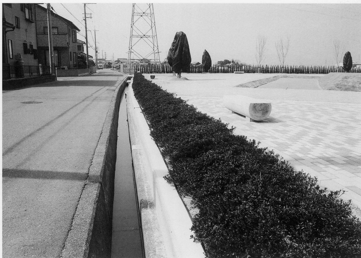
平成17年度保存整備工事 土留擁壁・サツキツツジ植栽・ベンチ
