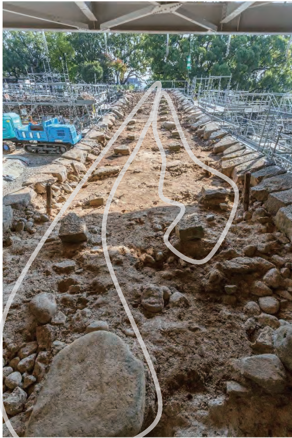
写真5 続櫓礎石検出状況（石垣解体前） 白枠内にある大きな石が礎石
