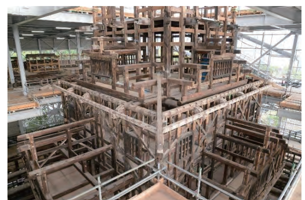
写真13 二重 軸部（垂木解体後）
