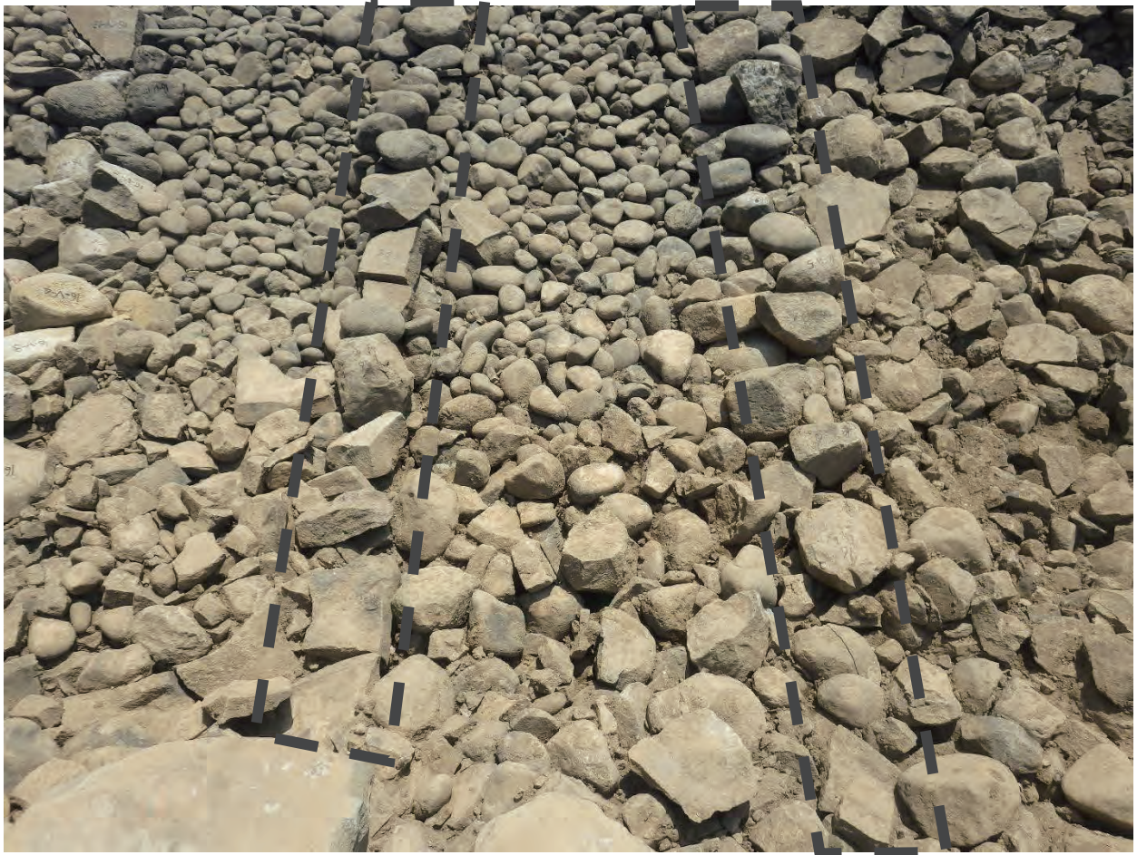
写真 13 西面石垣背面栗石内石列検出状況（黒破線内）
