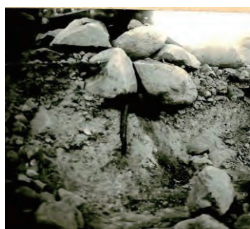
胴木と木杭の腐朽状況
