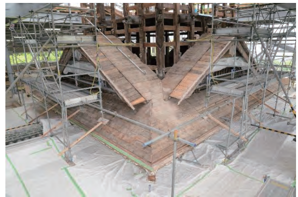
写真11 二重 野地板（瓦葺・土壁解体後）
