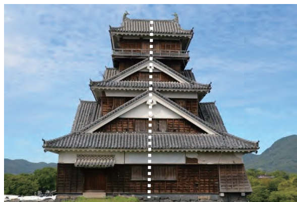
写真14 解体前宇土櫓（北に傾いている）
