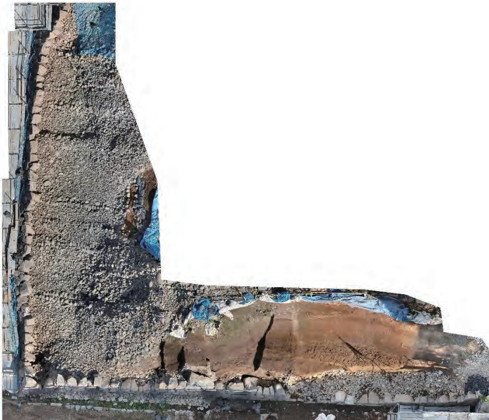
写真7 宇土櫓続櫓石垣 20 段目解体前平面写真（上が北）
