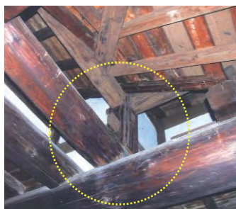
(熊本城宇土櫓) 3階の梁から立ち上がる4階5階の通し柱
