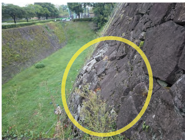
写真3 西面石垣被災状況（黄色枠内が変状部分）
