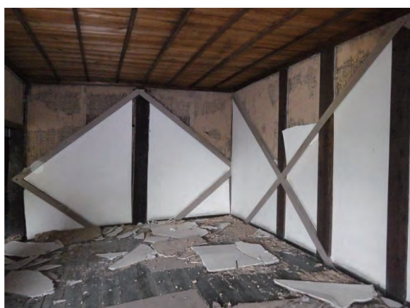
写真2 地震直後の剥がれ落ちた漆喰壁
