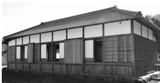
北面外部開口部西側
