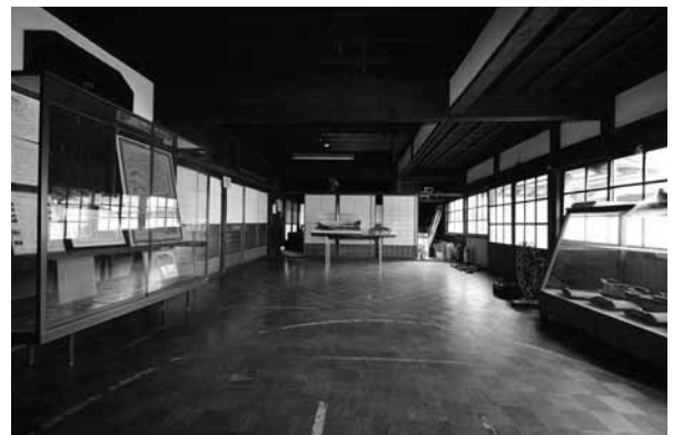
内部柱を抜いて板の間に改造
