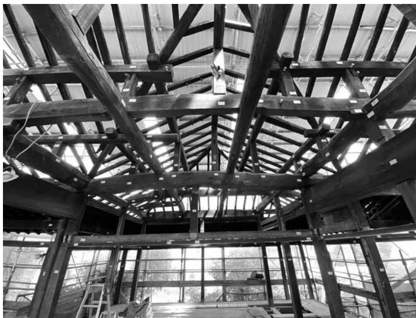
34. 野地板・壁等解体
