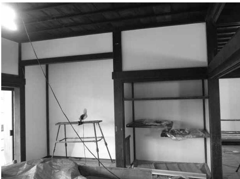
67. 内部漆喰塗り
