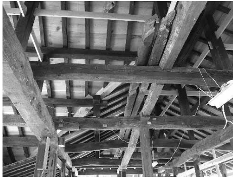
小屋裏保存状況
