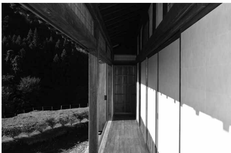
15. 居間・上の間外縁側西面
