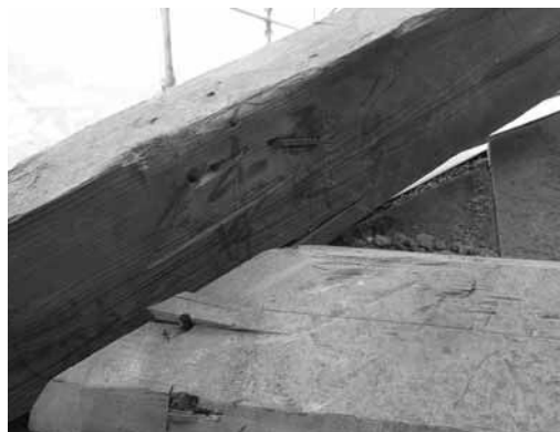
土居桁取り付け墨書（写真三）
