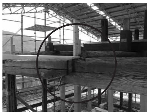
一通り桁東側 谷木痕跡
