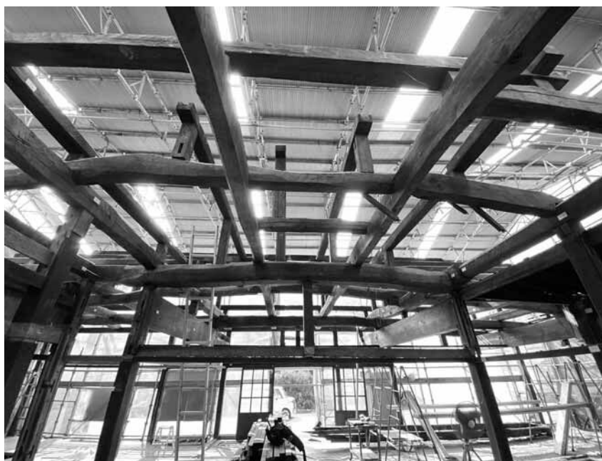
35. 垂木・造作材解体
