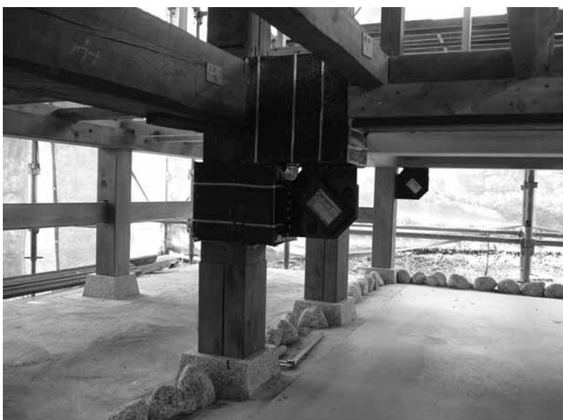
62. ガルコン柱・足固め 古材部分取付
