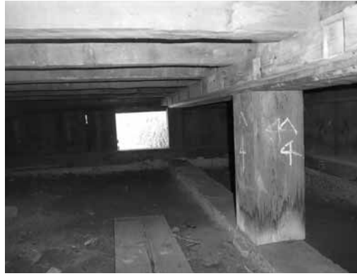
外部コンクリート基礎
