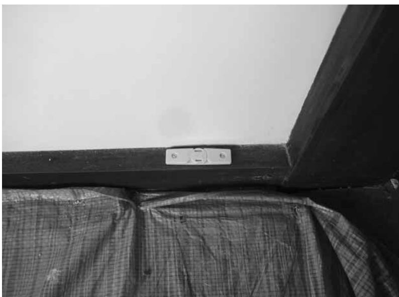
69. 電気器具取付 コンセント
