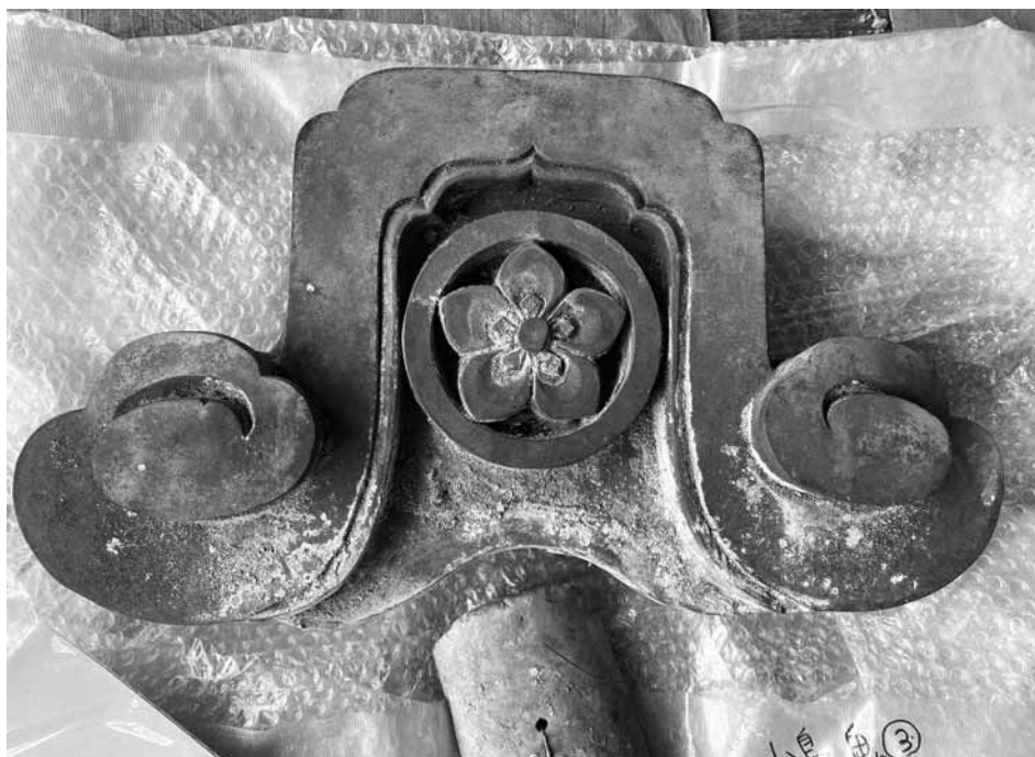
28. 復原製作瓦大棟鬼瓦
