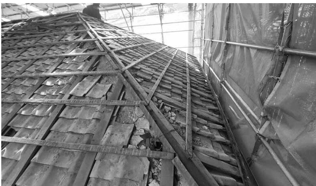
26. 屋根トタン撤去
