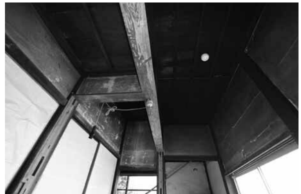
寝間の床の間・押入改造部分
