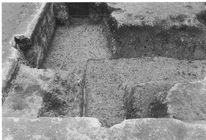
SD-1・南東隅部 (P-3区・北から)
