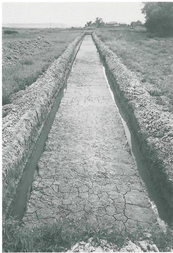
(3) C区トレンチ
