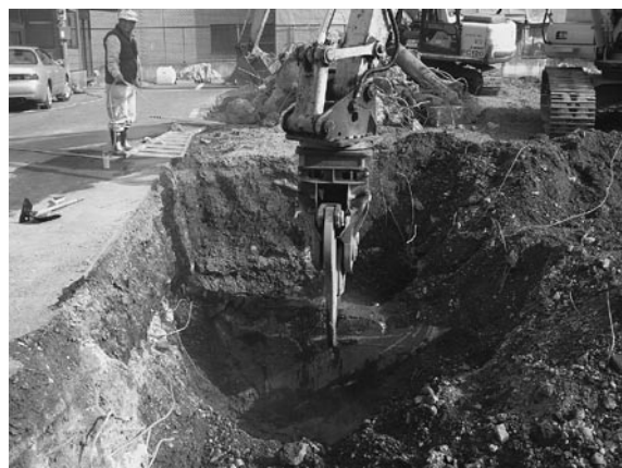
第16図 旧建物基礎撤去工事
