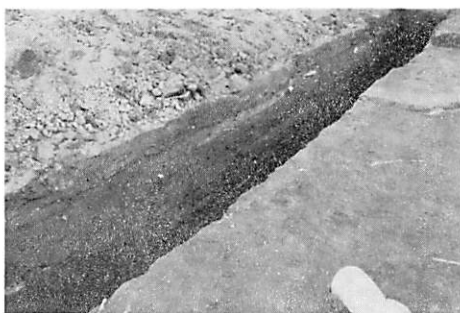
回廊基壇の掘込み地業
