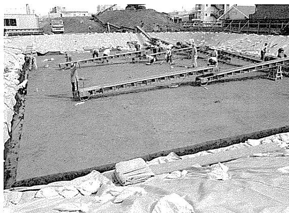
5 第1検出面小畦畔検出作業
