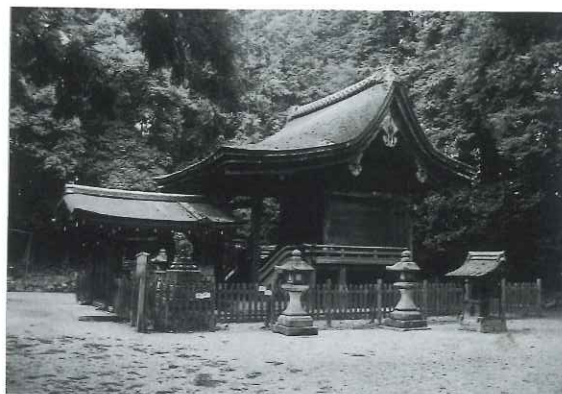
重要文化財小槻大社本殿
