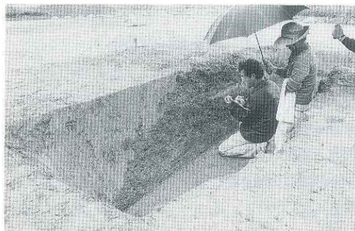
4 トレンチ 噴砂調査風景
