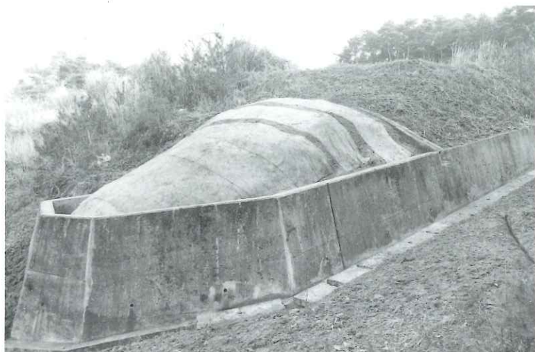
盛土除去後 保護シートの状況
