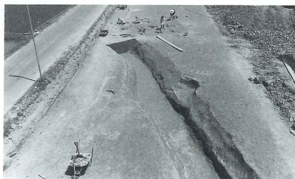
SD-1 調査状況
