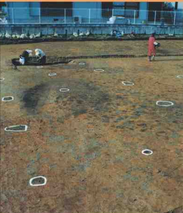
▲掘立柱建物検出状況
