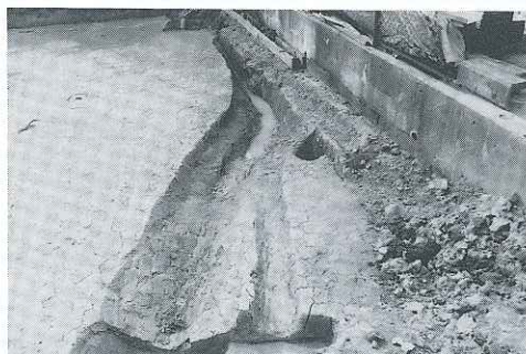
図9 SD-1(南から北方向を見る)
