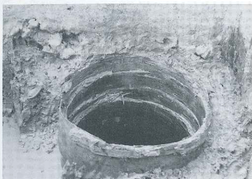
◀ S E-71 上部の方形枠 は、板材と竹 を用いている。 下部は、曲物 が9段重ねら れていた。
