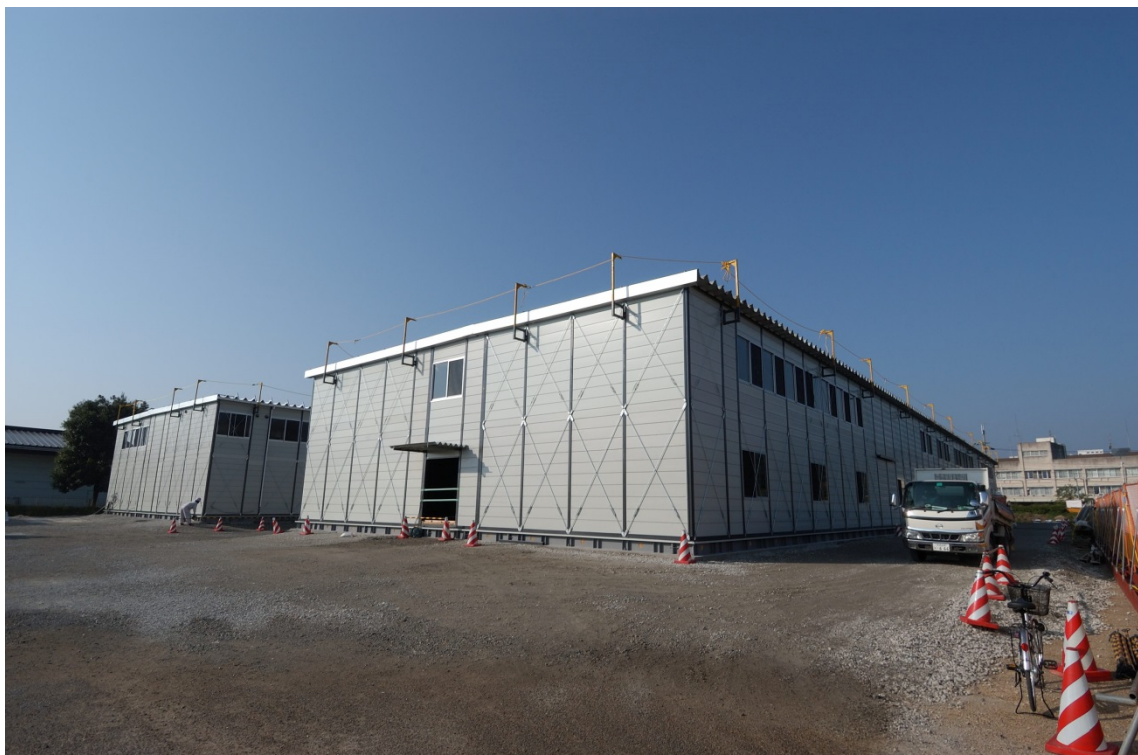
建物屋根・外壁完成
