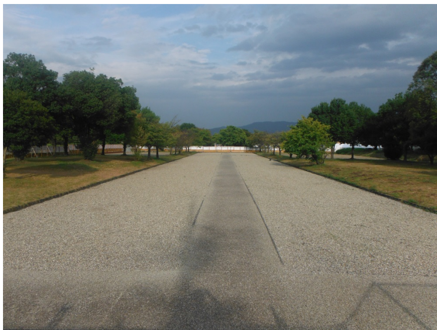
仮設庁舎設置現場（H25.8.29 佐伯門方向より撮影） 工事用フェンス設置後
