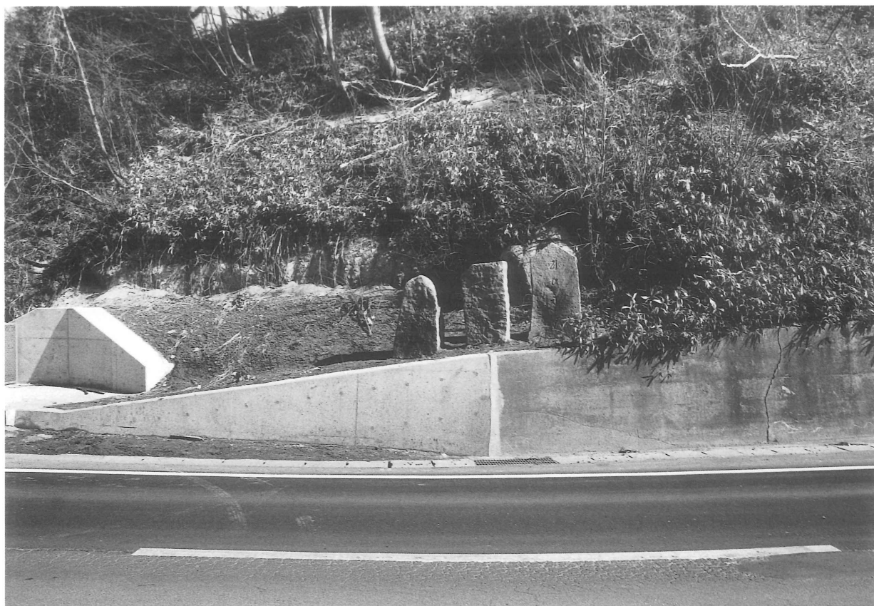
2 古御館地内板碑（西から）
