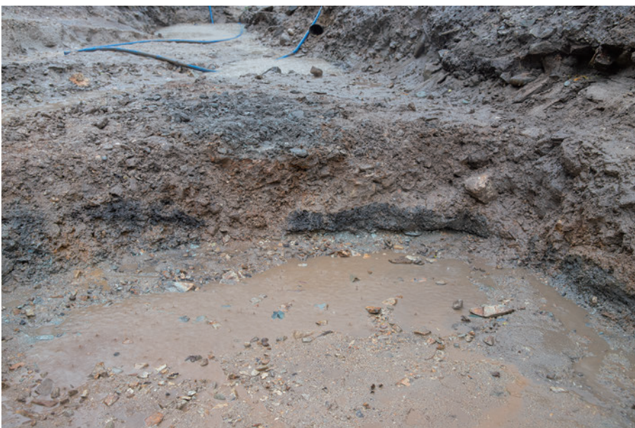
(3) A-A' 断ち割り土層断面 (南から)
