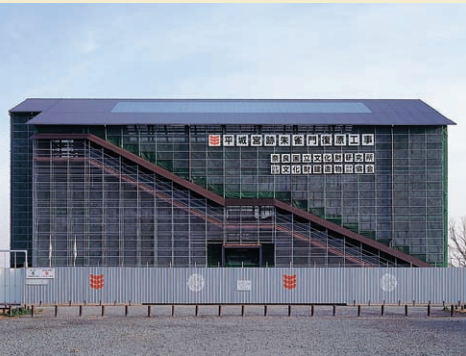
为施工而建的施工棚 （既可作为施工时的脚手架，又具有挡风防雨功能）
