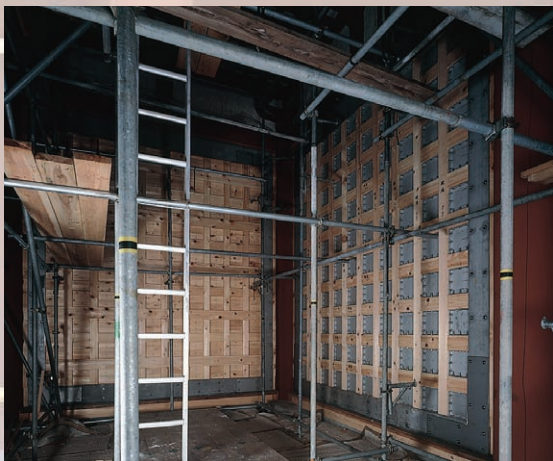
下层的墙壁内部
