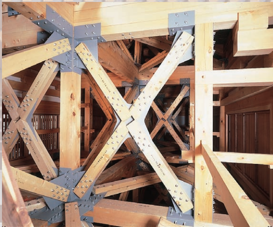
加入加固材料的上层内部
