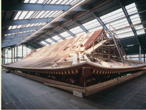
安装椽子，建造屋顶
