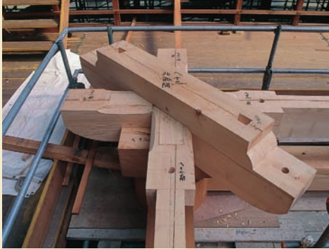
组装斗栱 （在柱子之上将各个建筑构件逐个组装起来）
