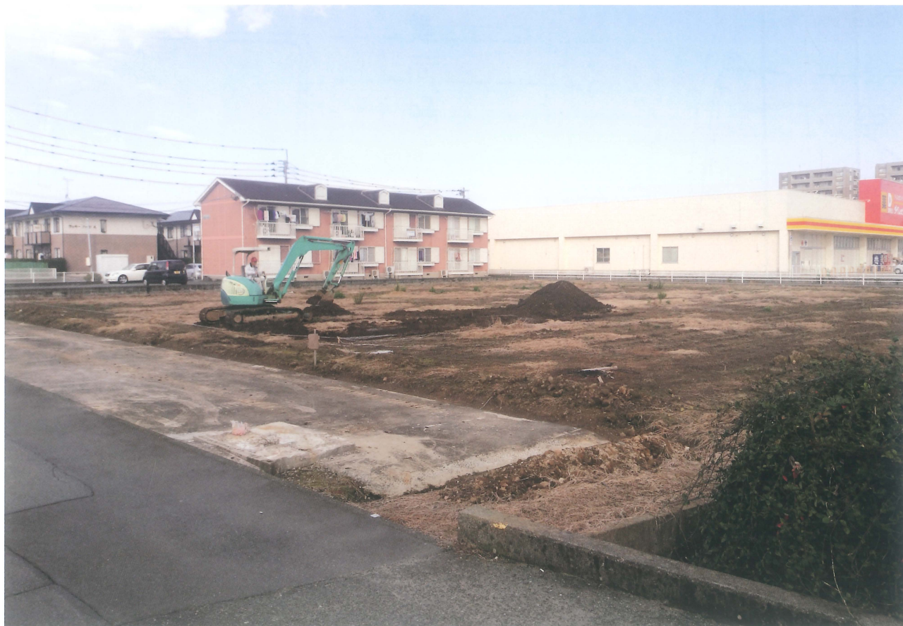
調査前風景および表土除去風景（南東より）
