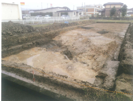
稲富・道免遺跡 2 区 SD03 (南西より)
